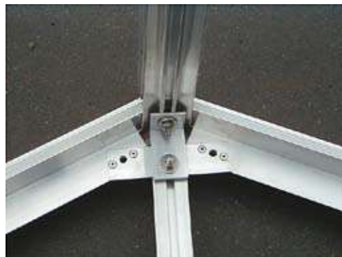
Sammanfogning av gavel sett från insidan vidnocken.
