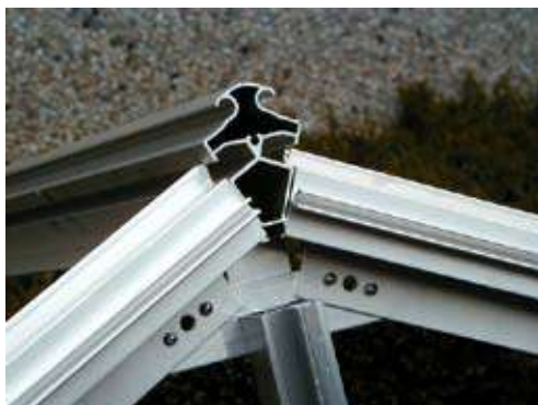
Sammanfogning av gavel sett utifrån vidnocken.
