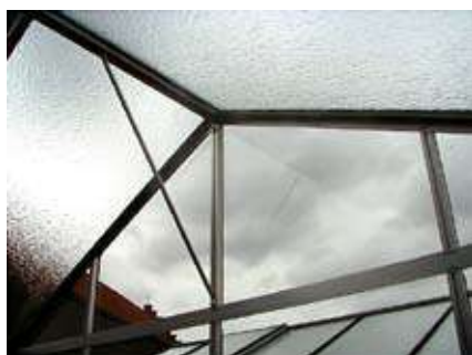
Sammanfogning hörnprofiler samt profil nr 6 vid takfoten.
