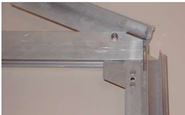
Sammanfogning hörnprofiler samt profil nr 6 vid takfoten.
