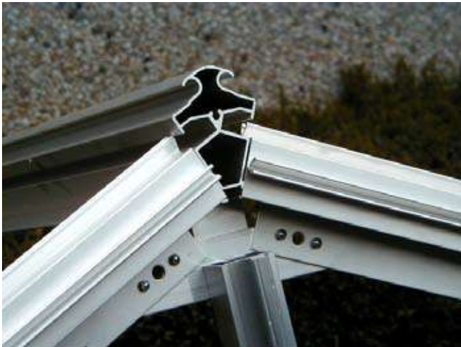
Sammanfogning av gavel sett utifrån vidnocken.
