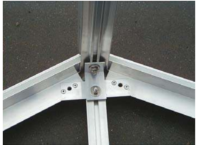
Sammanfogning av gavel sett från insidan vidnocken.
